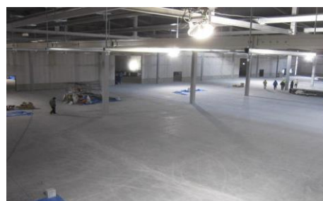
工場建設状況 (2016年3月10日時点) 工場内部
