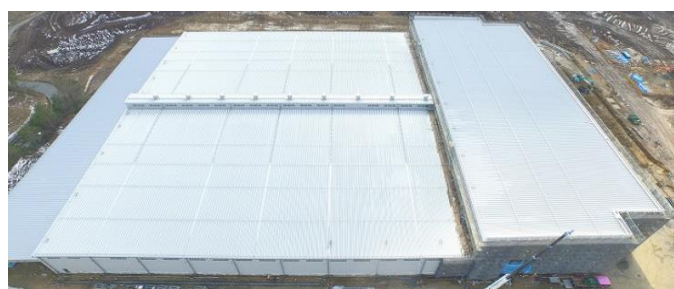
工場建設状況 (2016年3月10日時点) 工場外観
